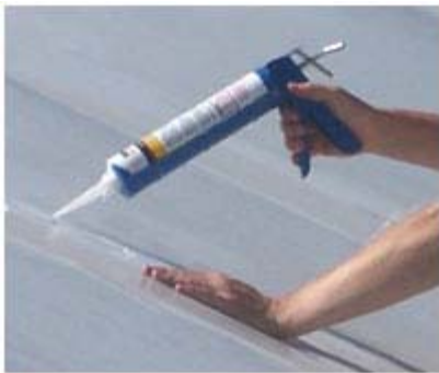
Figura 7: Sellado mediante pegamento siliconado en los bordes de la cinta.
